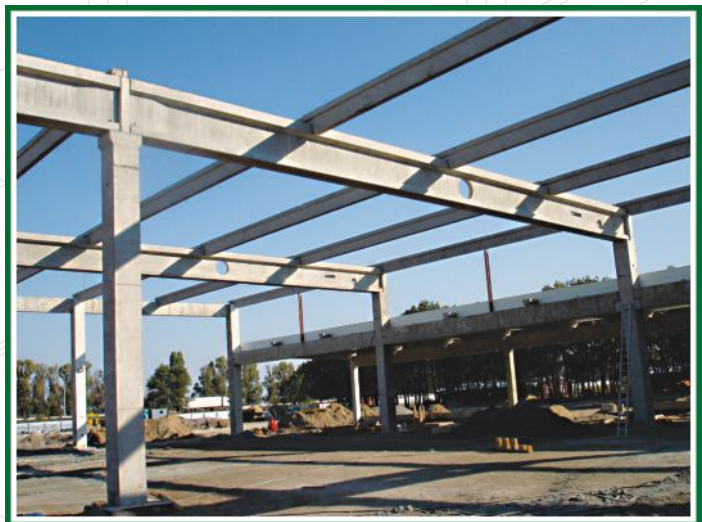
Каркас ТЦ „МЕТРО С&С”, м. Дніпропетровськ
