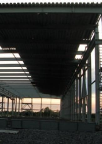
ла „КЕС-УА” проектування та будівництво залу змішаної конструкції загальною площею 4.000 м<sup>2</sup> в місті Нововолинськ. Під час проекту наша фірма разом з товариством „З Бетоні” виготовляли збірну залізобетонну конструкцію. До кола нашої роботи входило ще й облицювання фасаду будівлі.
